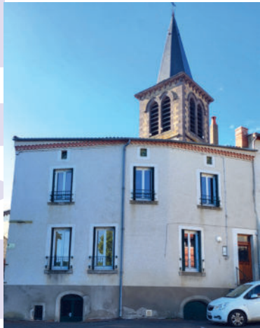
Réhabilitation et isolation de logements communaux 44 061 €
