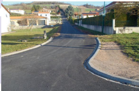
Remise en état de voiries 85 800 €
